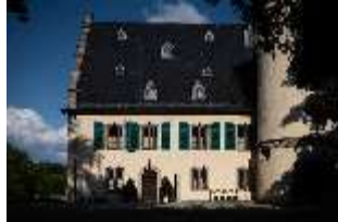
CoR.I, Westfassade mit Rundturm, DI025449, BSV-
