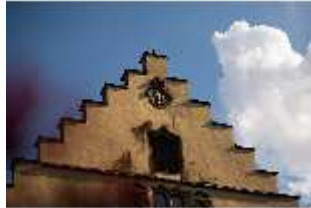
CoR.I, Giebel der Nordfassade, DI025458, BSV-
