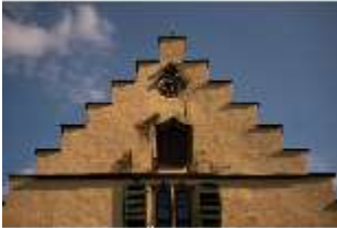
CoR.I, Giebel der Nordfassade, DI025457, BSV-
