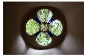
CoR.II, Vierpassfenster i. Treppenturm, DI025292, BSV-
