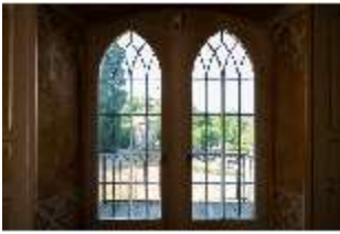
CoR.II, Nördl. Balkonzimmer, Fenstertüren, R. 9, DI025386, BSV-
