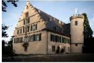
CoR.I, Nordfassade und Treppenturm, DI025443, BSV-
