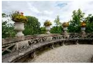
CoR.V, Schlossterrasse, Balustrade am Schalenbrunnen, DI005488, BSV
