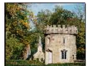
CoR.V, Rundturm, im Hintergrund ehem. Wagenremise, DE001234, BSV
