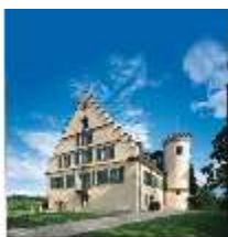
CoR.I, Ansicht von Nordwesten, DE000984, BSV
