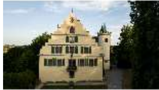
CoR.I, Luftaufnahme von N, DI025251, BSV-
