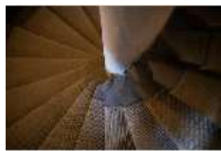
CoR.II, Wendeltreppe im Treppenturm, R. 4, DI025291, BSV-
