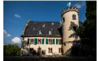
CoR.I, Westfassade mit Rundturm, DI025453, BSV-
