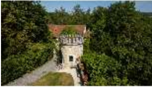
CoR.I, Luftaufnahme Rundturm, DI025247, BSV-
