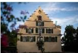
CoR.I, Nordfassade, DI025442, BSV-
