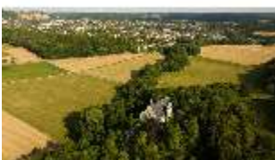
CoR.V, Luftaufnahme von NW, DI025261, BSV-
