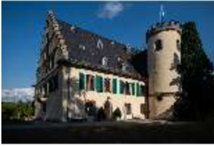
CoR.I, Nordfassade und Treppenturm, DI025451, BSV-
