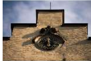
CoR.I, Giebel der Nordfassade mit Uhr, DI025459, BSV-
