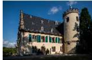
CoR.I, Westfassade mit Rundturm, DI025452, BSV-
