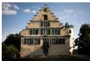
CoR.I, Nordfassade, DI025454, BSV-
